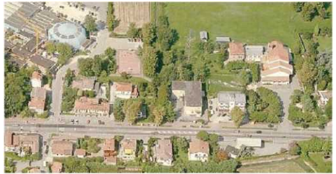
L'area Maccatrozzo alla Favorita in una foto aerea
